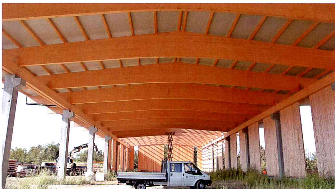
foto 1: esempio di parte della struttura portante del fabbricato allo stato grezzo
